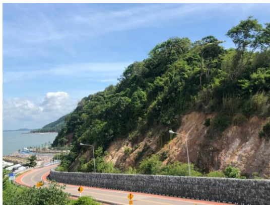
รูปที่ 4.1 การกัดเซาะที่ผิวหน้าของลาดดิน ก.) บริเวณเนินนางพญา จ.จันทบุรี ข.) การกัดเซาะที่ลาดเหนือคันทางริมถนนในพื้นที่อุทยานแห่งชาติเขาใหญ่ จ.นครราชสีมา
