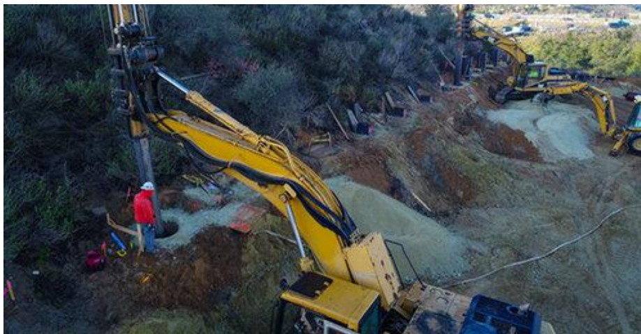
รูปที่ 5.19 ตัวอย่างการติดตั้ง Shear Pin ที่มา: D.J. Scheffler & Nye, Inc. (2022)
