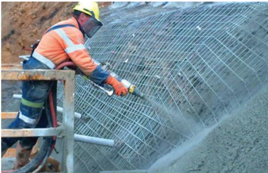
รูปที่ 5.21 Shot Crete งานสร้างถนนที่อยู่ใกล้บริเวณไหล่เขา
