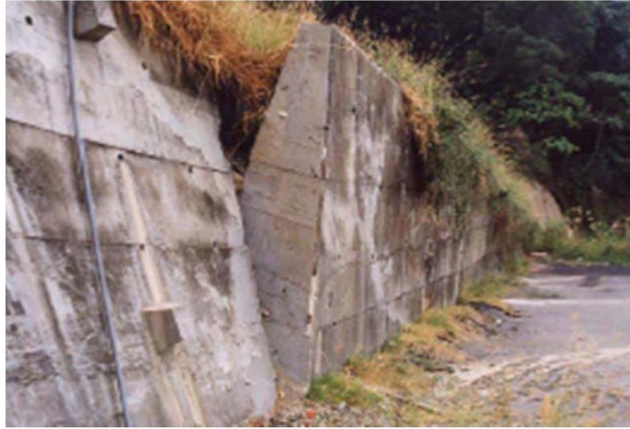
รูปที่ 5.3 การพังทลายของกำแพงกันดินเนื่องจากแรงแผ่นดินไหวที่ประเทศไต้หวัน ที่มา: Sitar et al. (2012)
