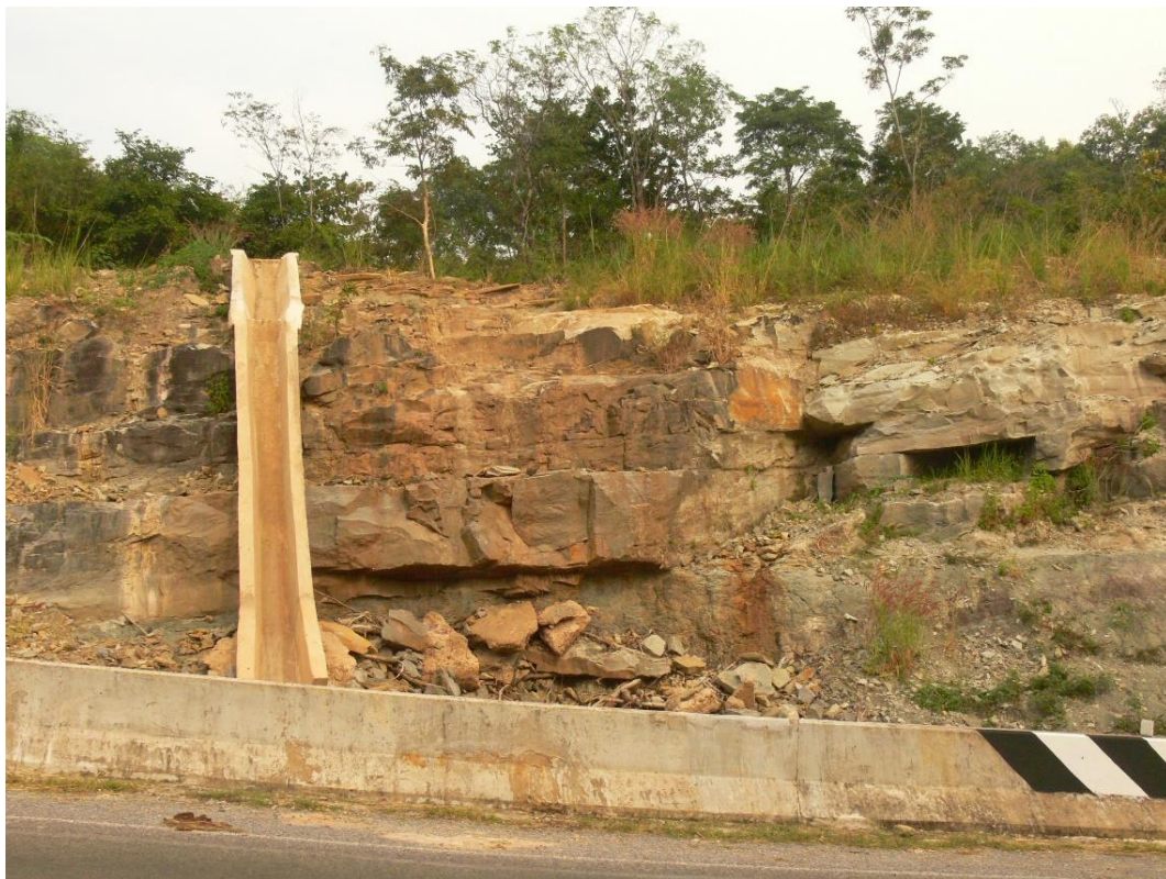
รูปที่ 1.6 ตัวอย่างการพังทลายเนื่องจากหินร่วง บริเวณทางหลวง 2291 กม. 42 จ.สกลนคร ถ่ายเมื่อปี พ.ศ. 2550
