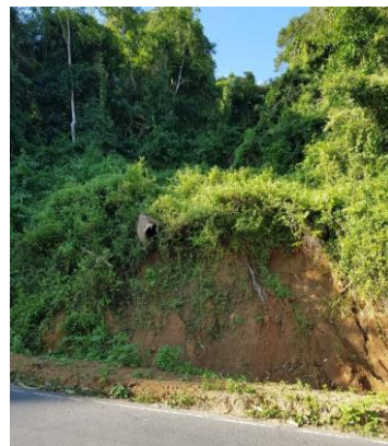
รูปที่ 4.1 การกัดเซาะที่ผิวหน้าของลาดดิน ก.) บริเวณเนินนางพญา จ.จันทบุรี ข.) การกัดเซาะที่ลาดเหนือคันทางริมถนนในพื้นที่อุทยานแห่งชาติเขาใหญ่ จ.นครราชสีมา
