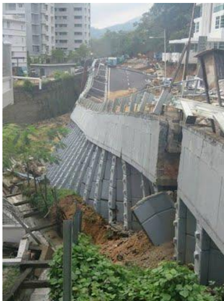
รูปที่ 5.2 การพังทลายของกำแพงกันดินเนื่องจากปริมาณน้ำที่ประเทศมาเลเซีย ที่มา: Jeffery (2018)
