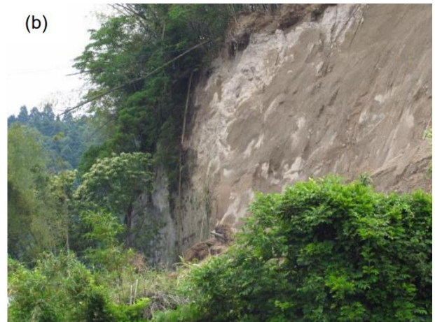
รูปที่ 5.22 ความเสียหายของ Shotcrete ระหว่างเกิดดินถล่มเนื่องจากแผ่นดินไหว Kumamoto a) บริเวณสะพาน Oogiribata b) เซึ่งลาดตั้งฉาก ซึ่งแสดงให้เห็นถึง Shotcrete นั้นหลุดร่วงไป แต่ดินเกิดความเสียหายน้อย
