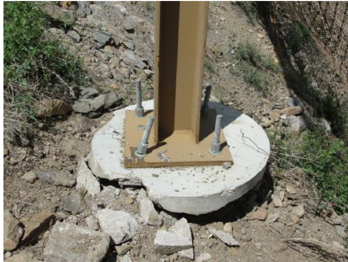
รูปที่ 5.29 ตัวอย่างความเสียหายที่เกิดขึ้นกับระบบป้องกันหินร่วง
