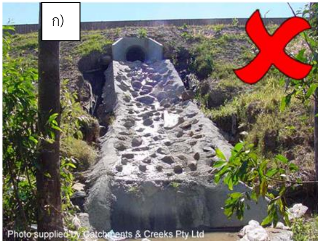
รูปที่ 6.12 ความเสียหายที่เกิดขึ้นกับ Drain Chute เนื่องจาก ก) การกัดเซาะบริเวณขอบเนื่องจากน้ำทะลักออกจาก Chute และ ข) การกัดเซาะเนื่องจากการใช้ขนาดหินที่ไม่เหมาะสม
