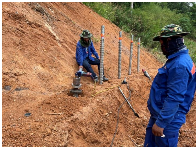
รูปที่ 5.20 การติดตั้งเสาะเข้มนเหล็ก
