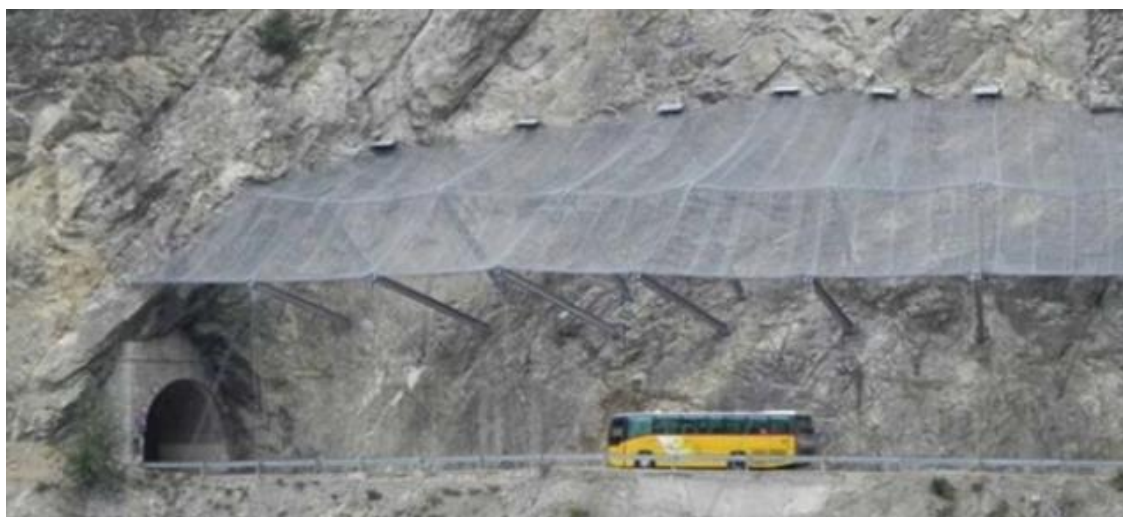
รูปที่ 5.26 อุโมงค์ป้องกันหินร่วง
