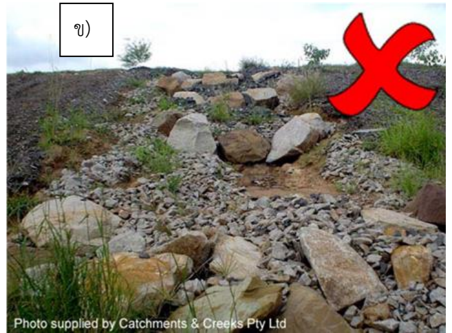
รูปที่ 6.12 ความเสียหายที่เกิดขึ้นกับ Drain Chute เนื่องจาก ก) การกัดเซาะบริเวณขอบเนื่องจากน้ำทะลักออกจาก Chute และ ข) การกัดเซาะเนื่องจากการใช้ขนาดหินที่ไม่เหมาะสม
