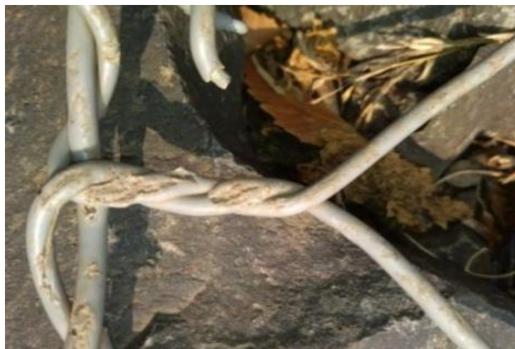
รูปที่ 5.5 การกัดกร่อนของลวดล่องเกเบียน
