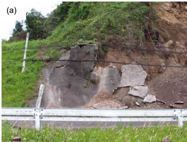
รูปที่ 5.22 ความเสียหายของ Shotcrete ระหว่างเกิดดินถล่มเนื่องจากแผ่นดินไหว Kumamoto a) บริเวณสะพาน Oogiribata b) เซึ่งลาดตั้งฉาก ซึ่งแสดงให้เห็นถึง Shotcrete นั้นหลุดร่วงไป แต่ดินเกิดความเสียหายน้อย
