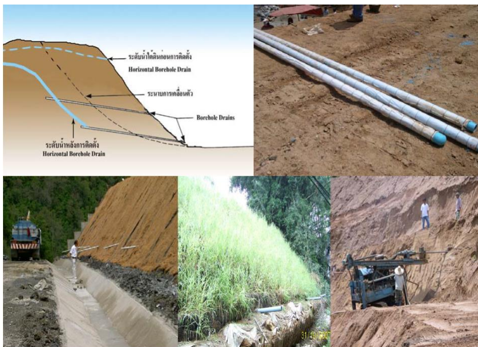
รูปที่ 6.14 ท่อระบายน้ำใต้ดินแนวราบ (Horizontal Drain) ที่มา: กรมทางหลวง (2555)
