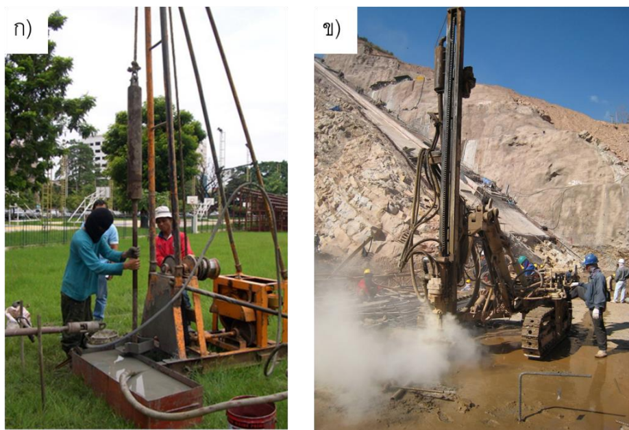
รูปที่ 2.20 การเจาะสำรวจดิน ก) การเจาะแบบฉีดล้าง ข) การเจาะแบบโรตารี
