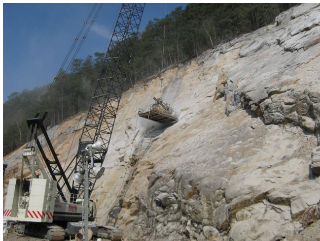
รูปที่ 5.32 การเจาะหินเพื่อติดตั้ง Rock Bolt
