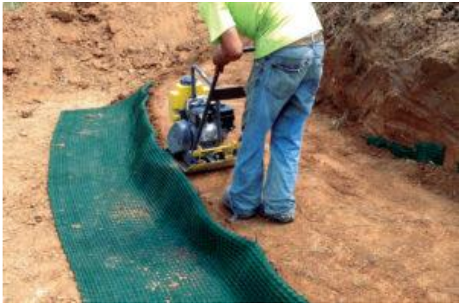
รูปที่ 5.13 การบดอัดดินด้านหน้า ที่มา: Miller (2017)
