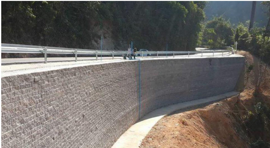
รูปที่ 5.8 กำแพงดินเสริมแรงที่ กจ.4088 กม. 8+700 จังหวัดกาญจนบุรี เมื่อแล้วเสร็จ ที่มา ประกิจ และคณะ (2562)
