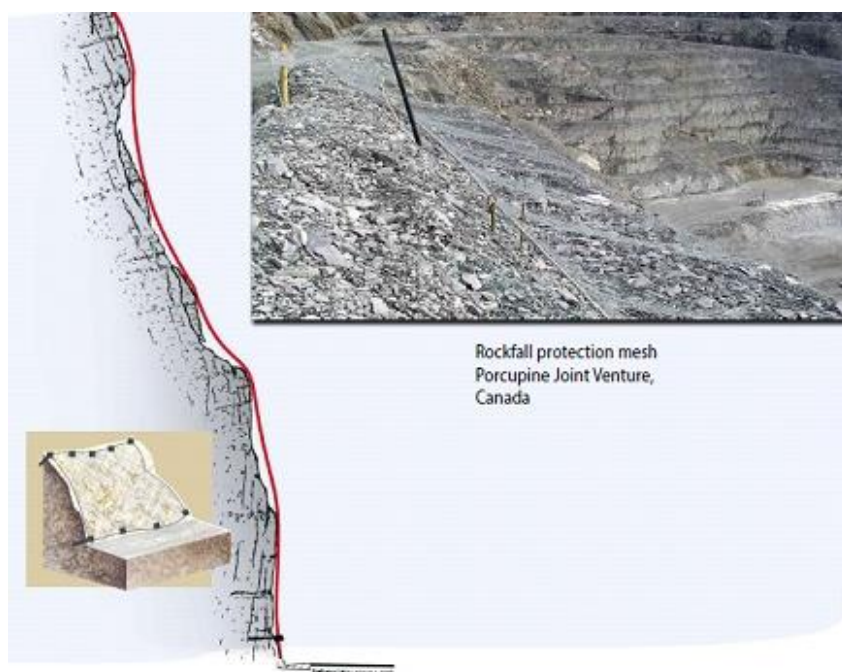
รูปที่ 5.23 ตาข่ายกันหินร่วง ระบบ Drapery
