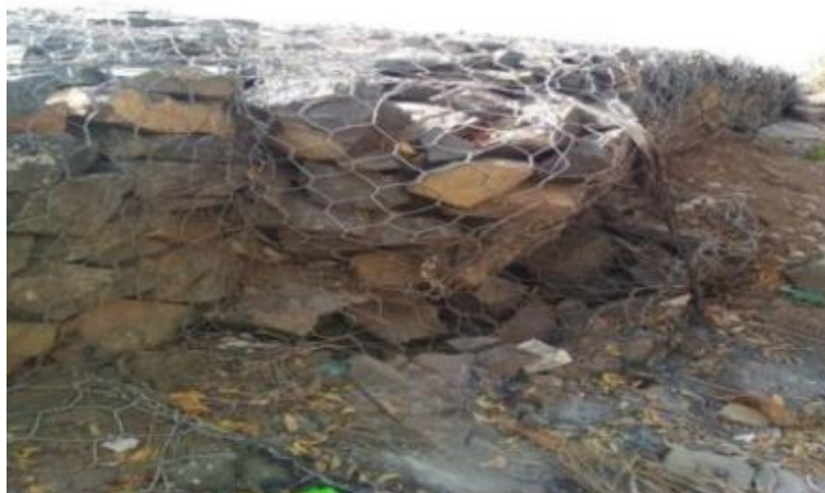
รูปที่ 5.6 การโป่งออกของหินภายในล่องเกเบียน
