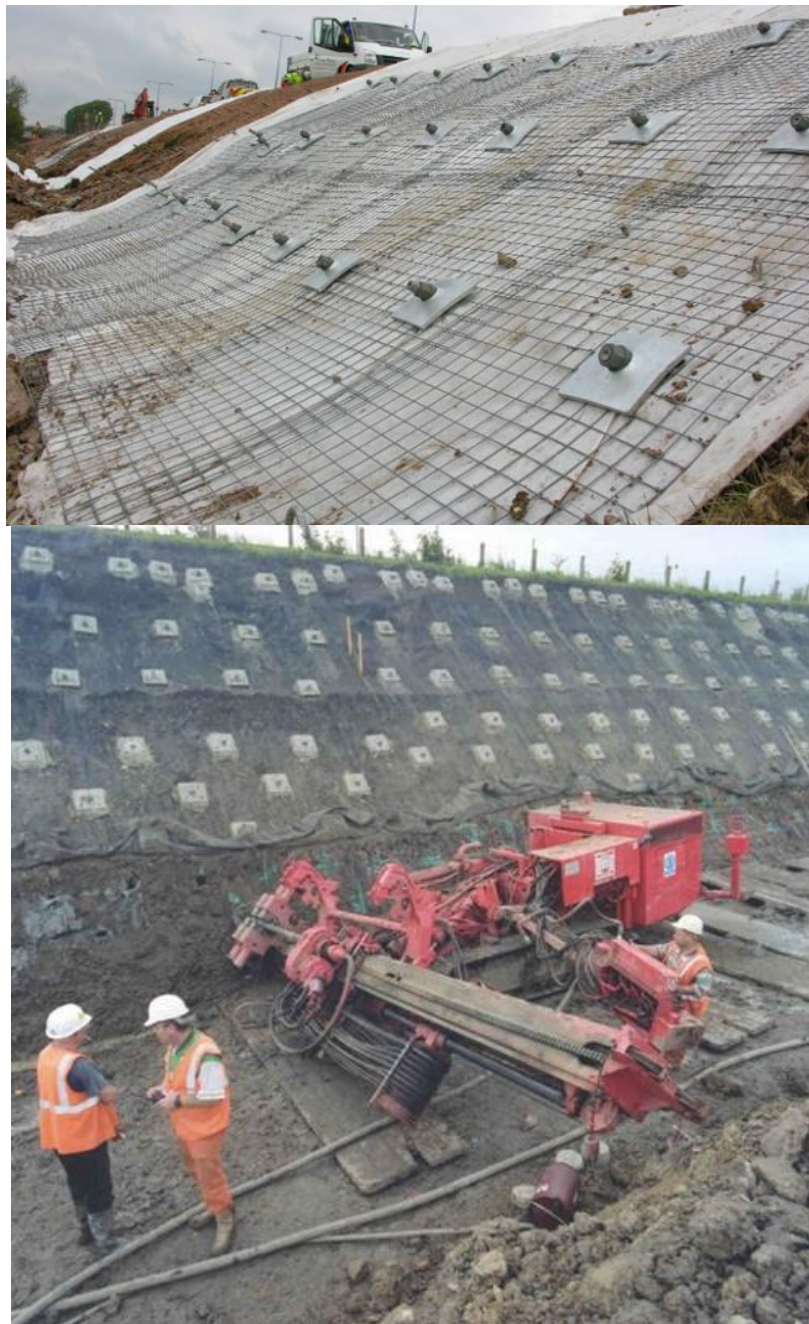
รูปที่ 5.15 การก่อสร้างกำแพง Soil Nail ที่มา: Bachy Soletanche (2016)
