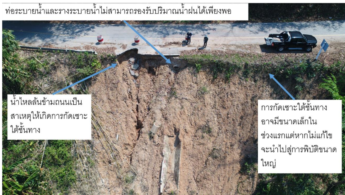
รูปที่ 1.4 ตัวอย่างการพังทลายเนื่องจากน้ำกัดเซาะผิวหน้าเชิงลาดและไหลทาง มีสาเหตุจากน้ำผิวดินและน้ำท่วมทาง ทางหลวงชนบท กจ. 4088 จังหวัดกาญจนบุรี ถ่ายเมื่อปี พ.ศ. 2565
