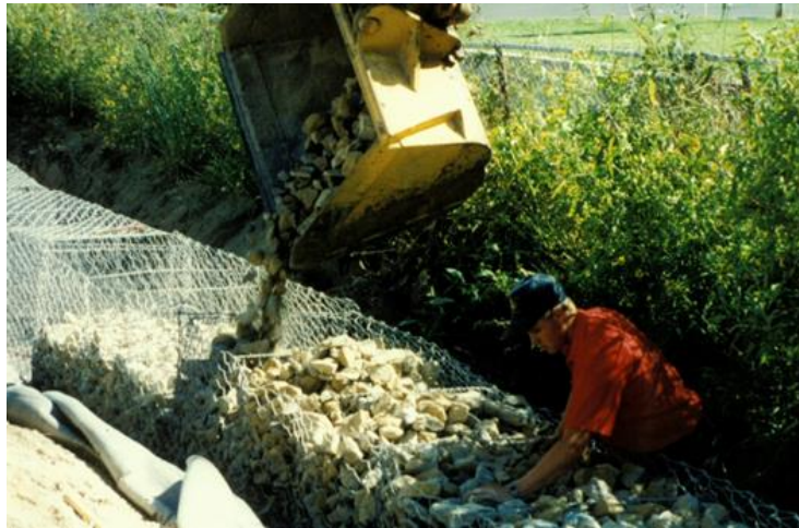
รูปที่ 5.4 การก่อสร้างกำแพงล่องเกเบียน
