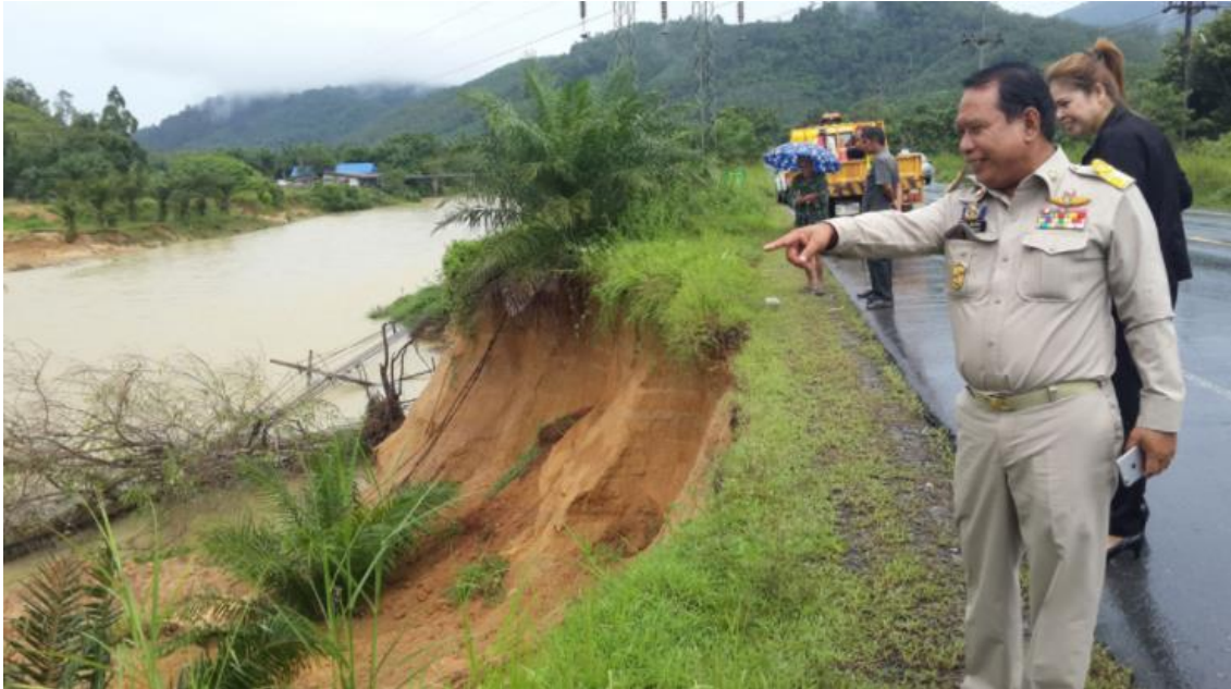
รูปที่ 1.1 ตัวอย่างการพังทลายเนื่องจากน้ำกัดเซาะบริเวณปลายเชิงลาดคันทาง (Erosion at Toe Slope) จากกระแสน้ำในแม่น้ำ ในจังหวัดพังงา เมื่อปี พ.ศ. 2558 ที่มา: ไทยรัฐออนไลน์ (2558)
