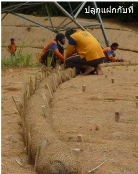
รูปที่ 4.11 การติดตั้งหมอนกันดินและผ้าห่มดินร่วมกับพืชพรรณ
