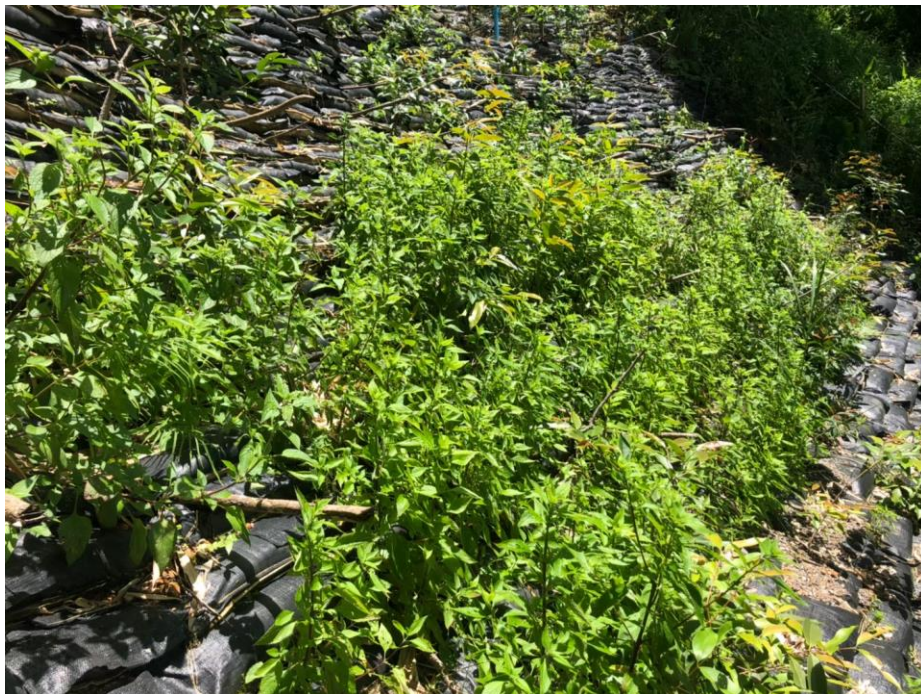
รูปที่ 4.15 การประยุกต์ใช้ท่อนพันธุ์ร่วมกับกระสอบแบบมีปีกที่ ทางหลวงชนบท กจ.4088 กม.16+700 อ.ทองพูนภูมิ จ.กาญจนบุรี ก.) 17 พฤศจิกายน 2563 ข.) 19 มิถุนายน 2564
