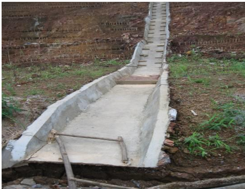
รูปที่ 6.13 การกัดเซาะบริเวณด้านข้างและบริเวณปลาย Drain Chute
