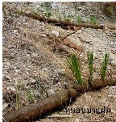
รูปที่ 4.11 การติดตั้งหมอนกันดินและผ้าห่มดินร่วมกับพืชพรรณ
